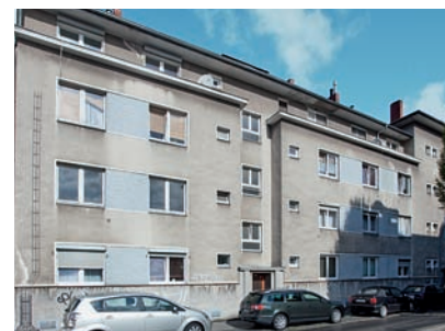
Bald ein Musterbeispiel für Energieeffizienz: das GAG-Gebäude in Ehrenfeld.
